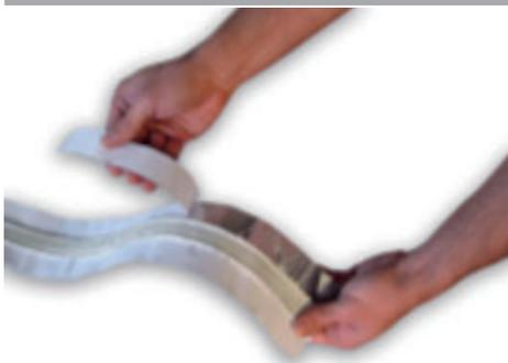
Entfernen Sie die Tape Abdeckung. Ziehen Sie die Ecken der Klebestreifen vorsichtig zurück und drücken Sie den Glasfasergewebestreifen nach außen.
